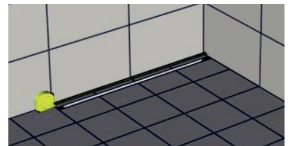
Naměřte potřebnou šířku kovového roštu.
